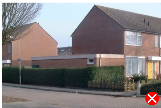
Zijaanbouw te dicht bij voorgevellijn
