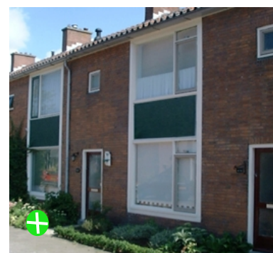
Bestaande indeling gerespecteerd bij vervanging
