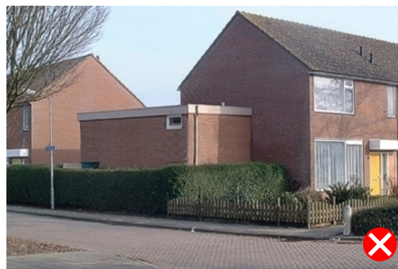
Zijaanbouw te hoog
