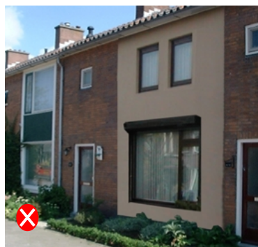
Nog meer verstoring door afwijkend materiaal voor kozijnen en gevelvlak
