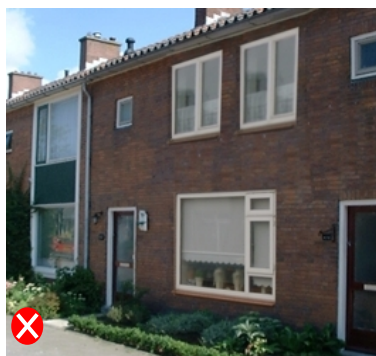
Samenhang straatbeeld verstoord door afwijkend kozijn
