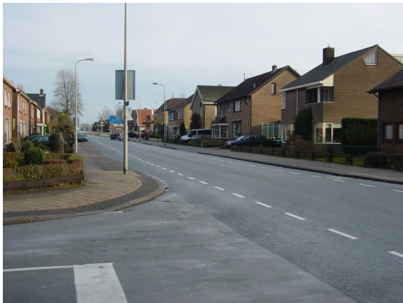
Denekamperstraat: Twee bouwlagen met kap
