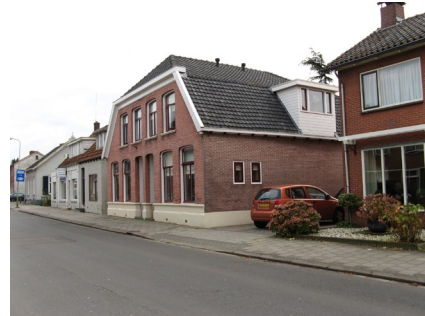
Verschillende materialen, kleuren, verticale gevelindeling, details
