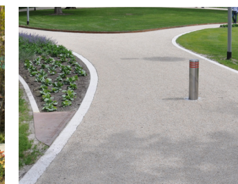
Afb. 13. paden in singelpark: asfalt met strooilaag warme zandkleur
