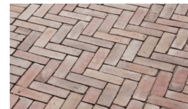
Afb. 10. Gebakken klinkers in twee mixen, aansluitend bij binnenstad ( Plechelmus mix voor pleinen &amp; rijbaan Aansluitend bij straten binnenstad voor walpad, muur wadi &amp; parkeervakken)
