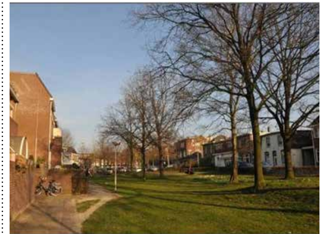
Afbeelding 3.7 Locatie Kloosterstraat/ Noordwal. De oude muur ligt vrijwel 'grijpbaar', aan de oppervlakte. Een locatie voor consolidatie van de muur.
