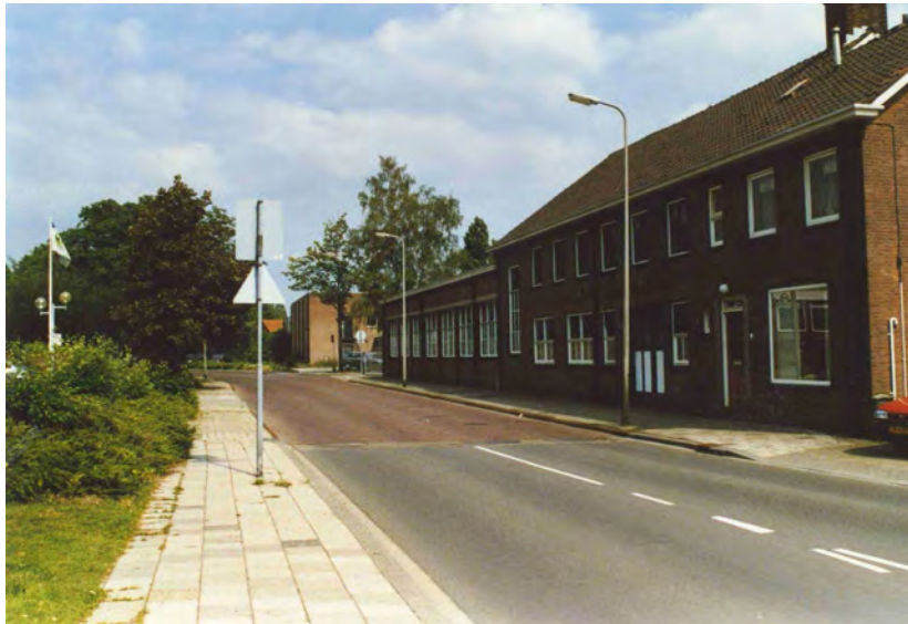
Foto uit 2007 vlak voor de sloop van het dienstgebouw aan de Bisschop Balderikstraat 2-4
