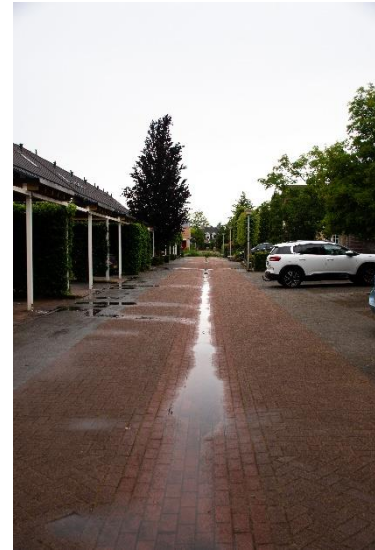
Figuur 3.2 Afgekoppeld verhard oppervlak in de Graven Es: hemelwater stroomt vanuit de dakgoten naar het verlaagde deel van de weg. Vandaaruit stroomt het naar wadi's of oppervlaktewater.
