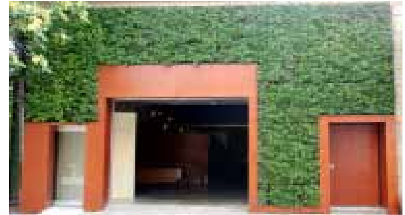
Groene muren en gevels aan boszijde
