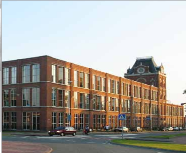
Referentiebeeld bakstenen gevels, twentse industrie
